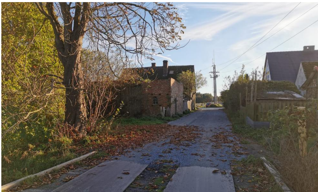
Droga nr 2 na wysokości posesji Uniemyśl 37B – mostek nad rzeką Karpiną – widok w stronę południową
